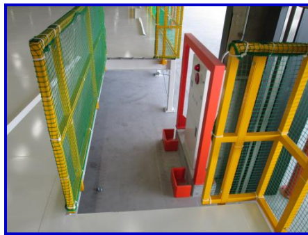
消防設備周辺
